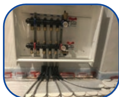
5.- Colocação dos tubos dos diferentes circuitos.
