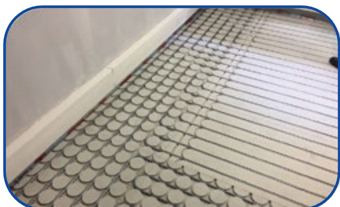
6.- Efetuar o teste de pressão. Uma vez terminado o teste de pressão, verter a argamassa autonivelante.
