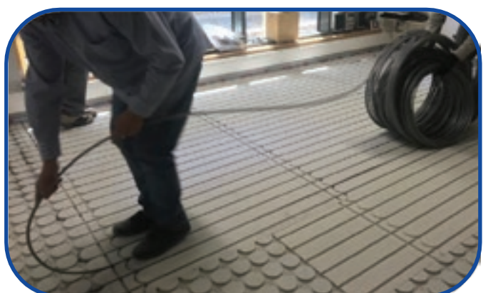
5.- Colocação dos tubos dos diferentes circuitos.
