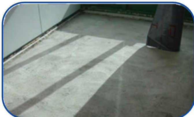
1.- Preparação da betonilha. A superfície deve estar limpa e plana.
