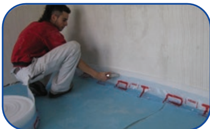
3.- Instalação da fita perimetral em todos os parâmetros verticais.
